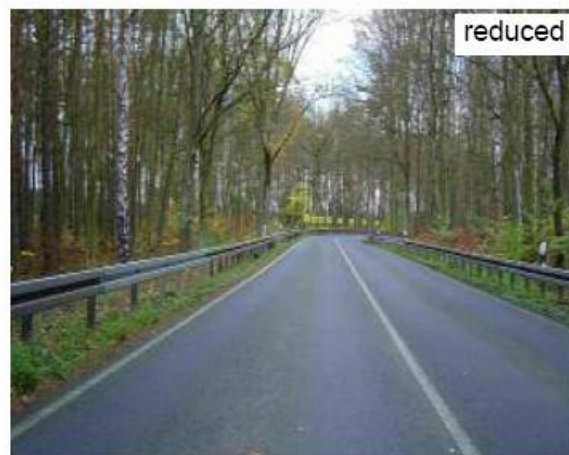
شکل 3-14: مسیر غیر قابل رؤیت در یک پیچ خطرناک
