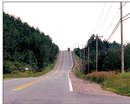
خطوط کمکی در شیب‌های سربالایی برای مانورهای ایمن و سبقت ایجاد فضای مناسب همگرایی در راه
