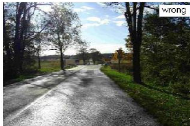
شکل 3-11: تغییر ناگهانی در مشخصات راه: تقاطع جدید با ناحیه انتقالی اصلاح‌شده اطلاع‌رسانی نشده است (150 متر جلوتر)
