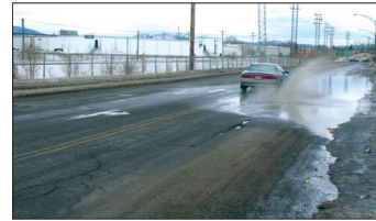
مشکل انباشتگی آب در سطح راه قیرزدگی از مشکلات مربوط به روسازی‌های آسفالتی
