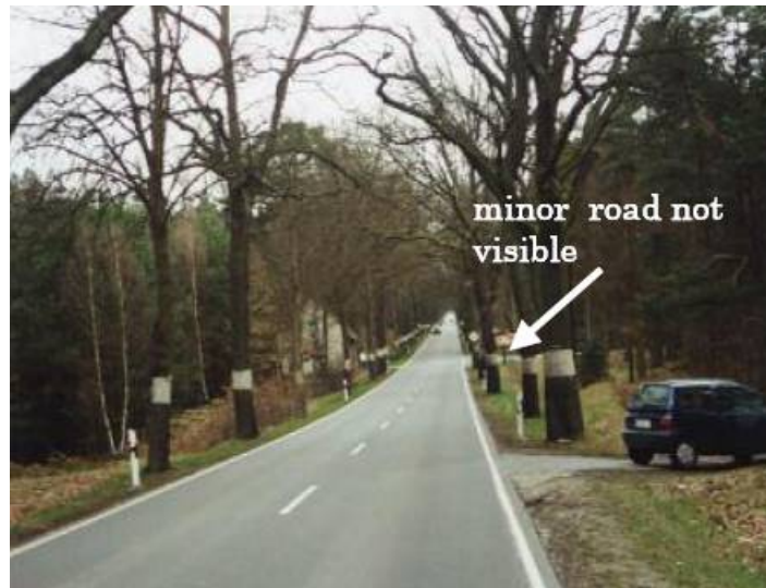
شکل 3-3: راه فرعی که به موقع قابل رؤیت نیست؛ خطر وقوع تصادف در اثر سرعت بالا و ترمزگیری پیش‌بینی نشده
