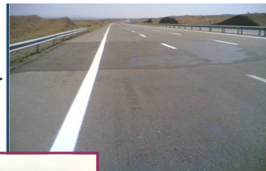
مشکل انباشتگی آب در سطح راه قیرزدگی از مشکلات مربوط به روسازی‌های آسفالتی
