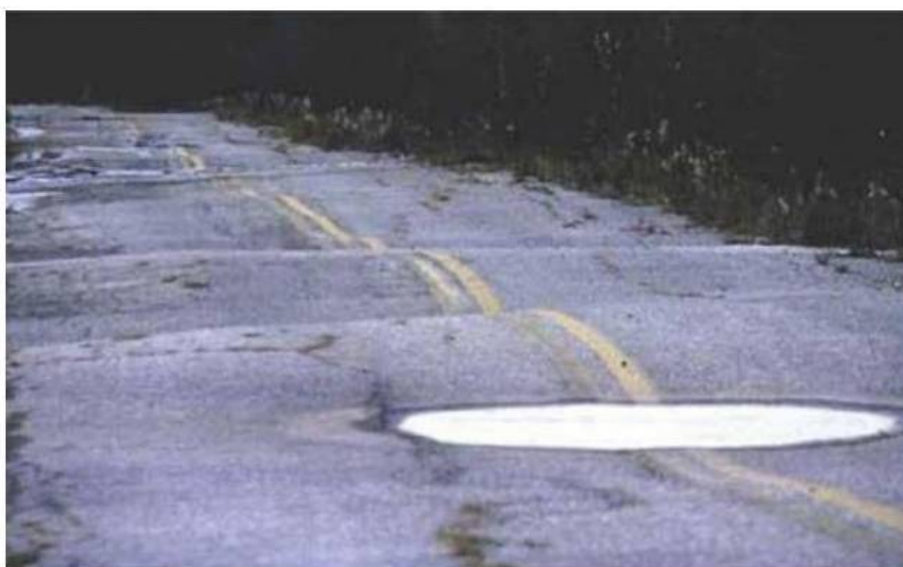
شکل ۲- ذوب لایه‌های منجمد خاکی و نشست خاک در آلاسکا
