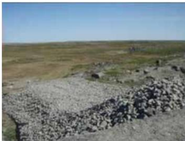
شکل ۱۲ - سیستم حفاظتی در دست ساخت در لبه باند فرودگاه Puvirnituk
