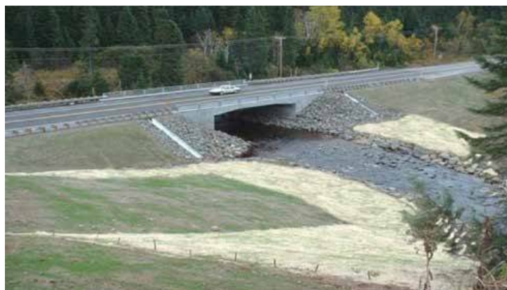
عکس 4C- سنگ‌چین در هر دو طرف مسیر رودخانه
