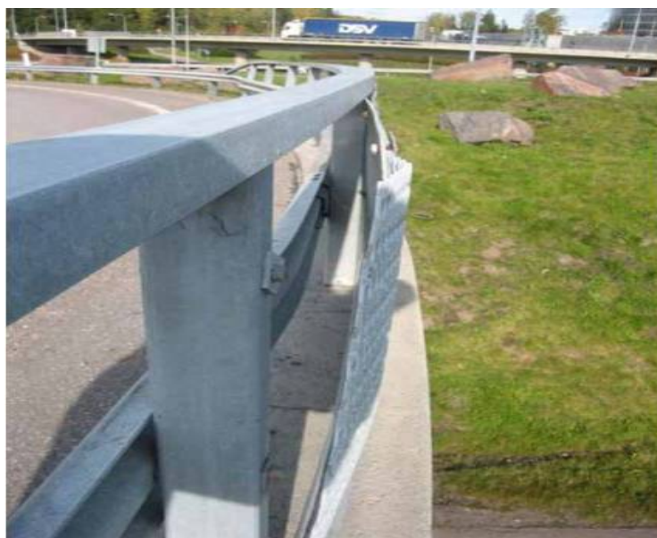
شکل ۴- جدا شدن قطعه حصار برف گیر
