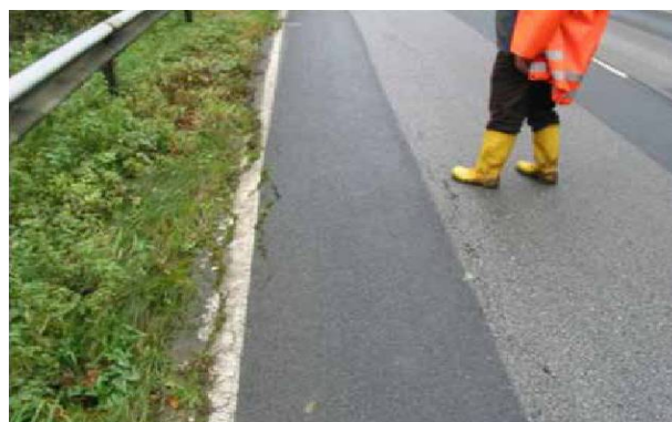
شکل ۳- ترک در سطح راه فدرال B3 با روسازی آسفالتی، ناشی از رانش آرام زیرزمینی
