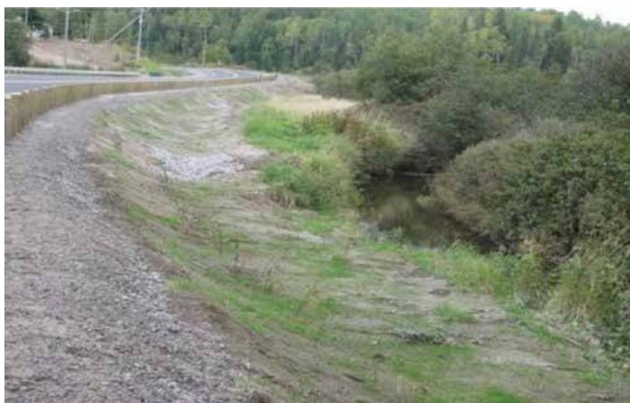
عکس 4B- بازسازی به‌وسیله بالا بردن ارتفاع سطح راه
