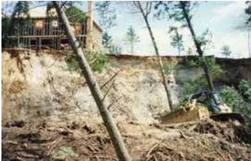
شکل ۴- نمونه‌ای از رانش زمین که باعث ایجاد شکاف در مجاورت یک واحد مسکونی شده است. در تصویر یک بولدوزر در حال غلتیدن بر اثر شدت جریان گل‌ولای و تخریب زمین است.
