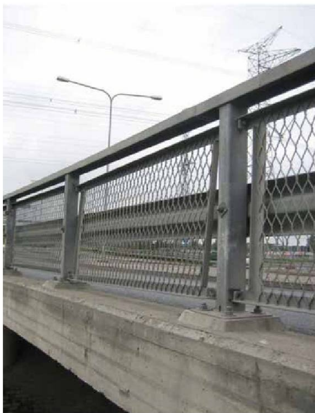
شکل ۱- نبود چفت‌وبست در بخش پایینی حصار برف‌گیر
