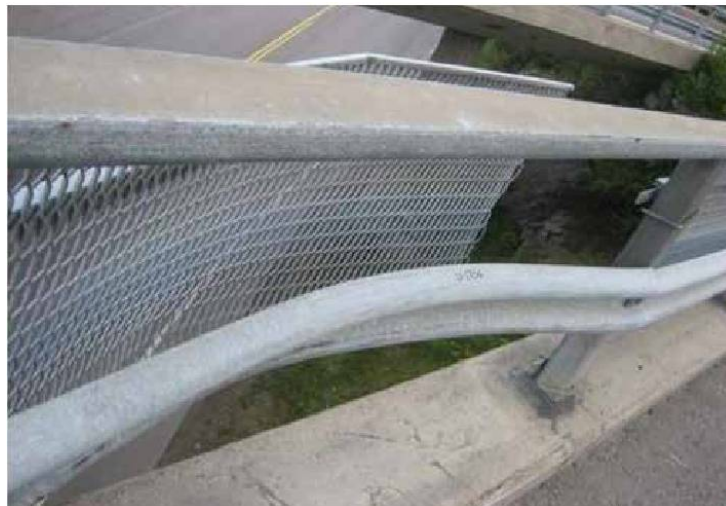
شکل ۳- شل شدن انتهای حصار برف گیر و شکستگی چفت و بست ها
