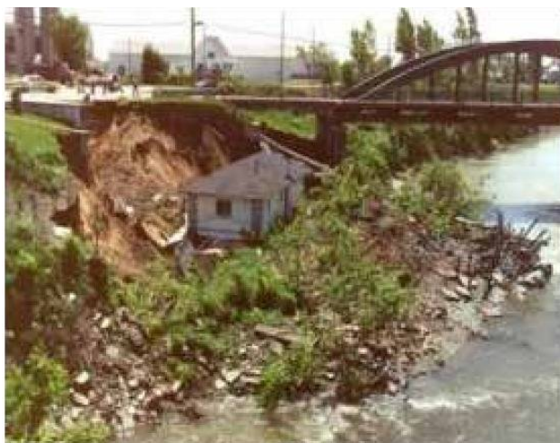
شکل ۱- نمونه‌ای از چرخش عمیق لایه‌های رسی در راه‌های آبی، ۱۹۹۰
