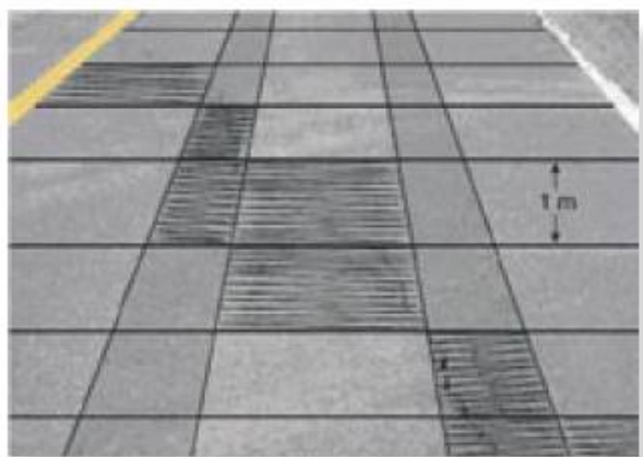
شکل 3. برداشت وسعت ترک‌ها به وسیله سلول‌ها
